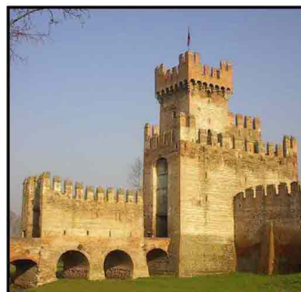
La cinta muraria di Montagnana
